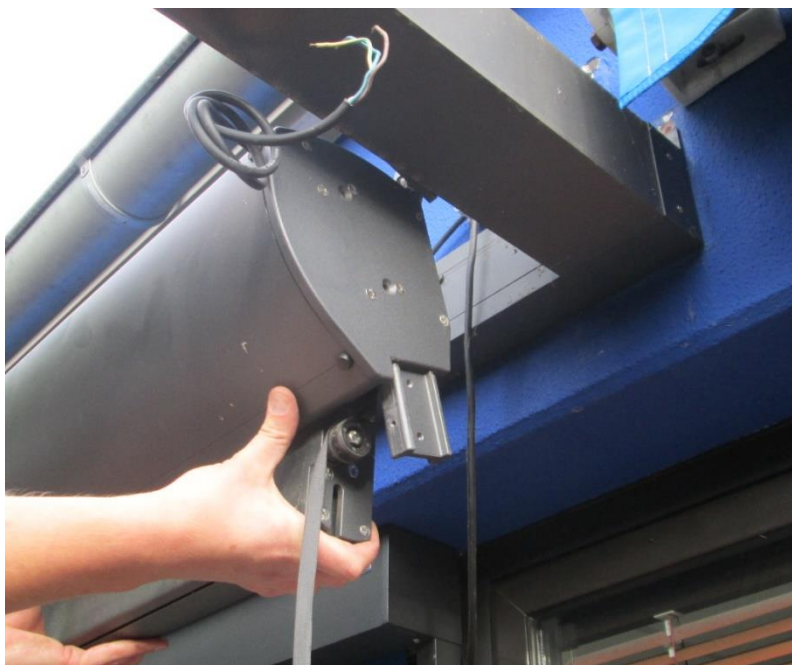
Abbildung 7: Kasten abnehmen
