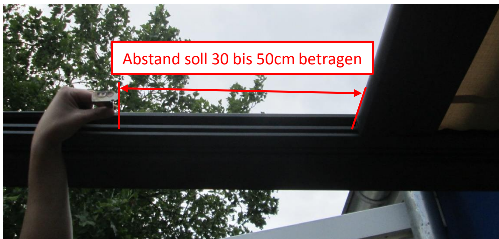
Abbildung 24: Gurtspannung prüfen
