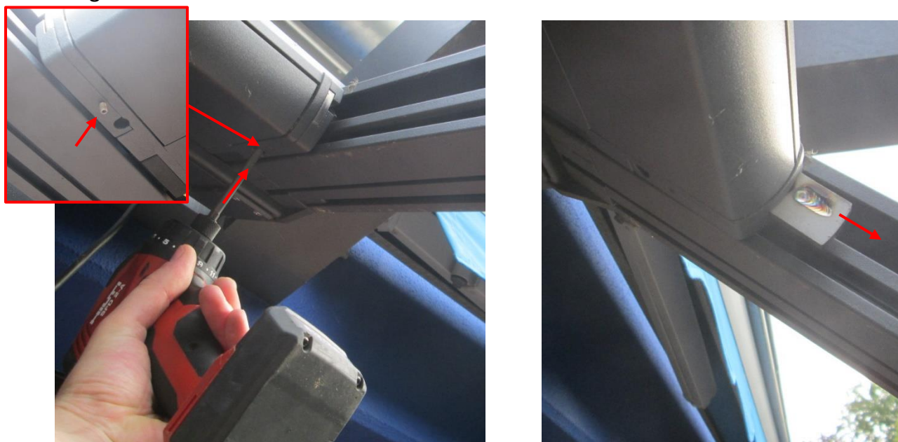
Abbildung 4: Gurt mit Schnapphaken entfernen
