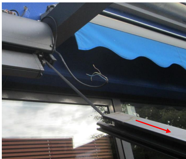
Abbildung 5: Führungsschienen abnehmen
