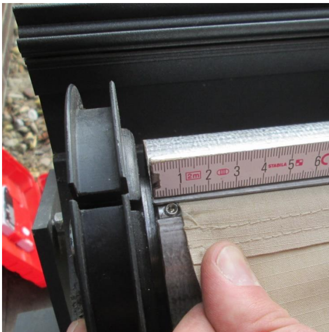
Abbildung 19: neues Tuch ausmitteln und beim Aufwickeln führen
