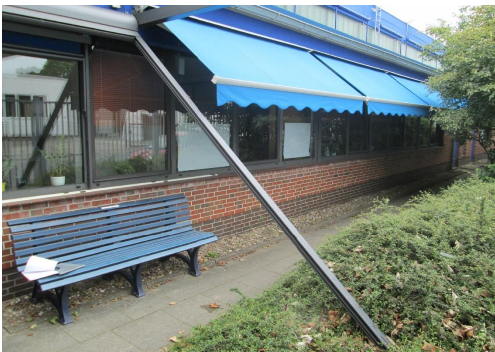
Abbildung 2: Ausfallprofil nach vorne wegschieben und Führungsschienen ablegen
